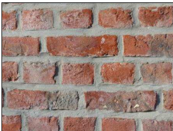
Mur fait de briques en panneresses et en boutisses
