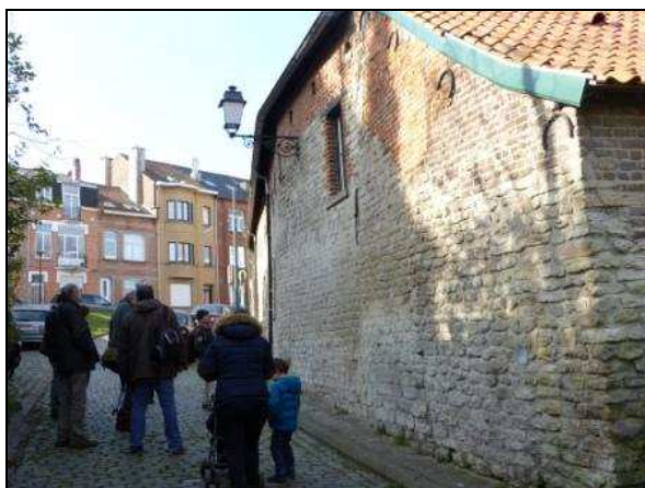
La fermette avec ses briques et ses moellons de grès calcaire
