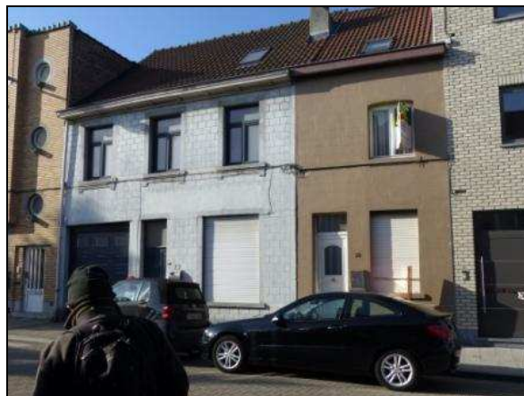
Ancienne ferme aux murs de briques recouvertes d'un enduit
